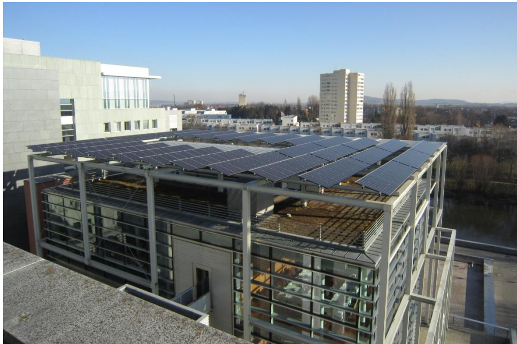
Abb: LS-Sonnenstrom-Kraftwerk im Regierungsviertel St. Pölten
